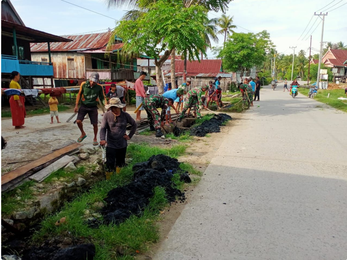
Gotong royong tersebut digelar di Desa Parappe, Kecamatan Campalagian, Kabupaten Polewali Mandar, Sulawesi Barat. Minggu (21/1/2024). Karya bakti ini Kita fokuskan di saluran drainase karena air tidak mengalir dengan baik. Kata Letda Inf Muh Ilham, Danramil Campalagian.
