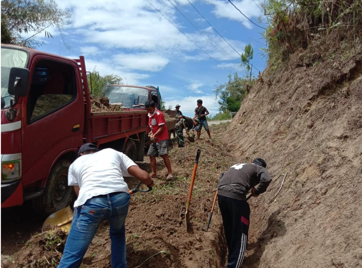
Dalam kesempatan itu, Babinsa dan masyarakat bahu membahu bergotong-royong membuat saluran air dan penimbunan Badan Jalan guna memperlancar aliran air dan mencegah terjadinya genangan air di badan jalan.
